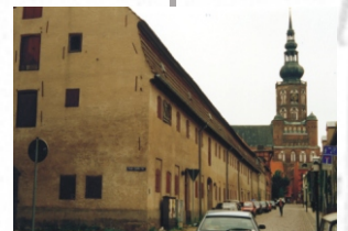
Vor der Sanierung
